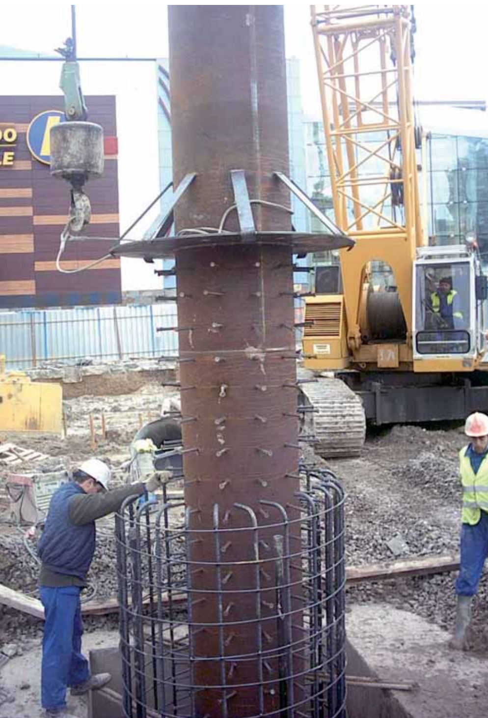
Pila pilote / Pile pier
