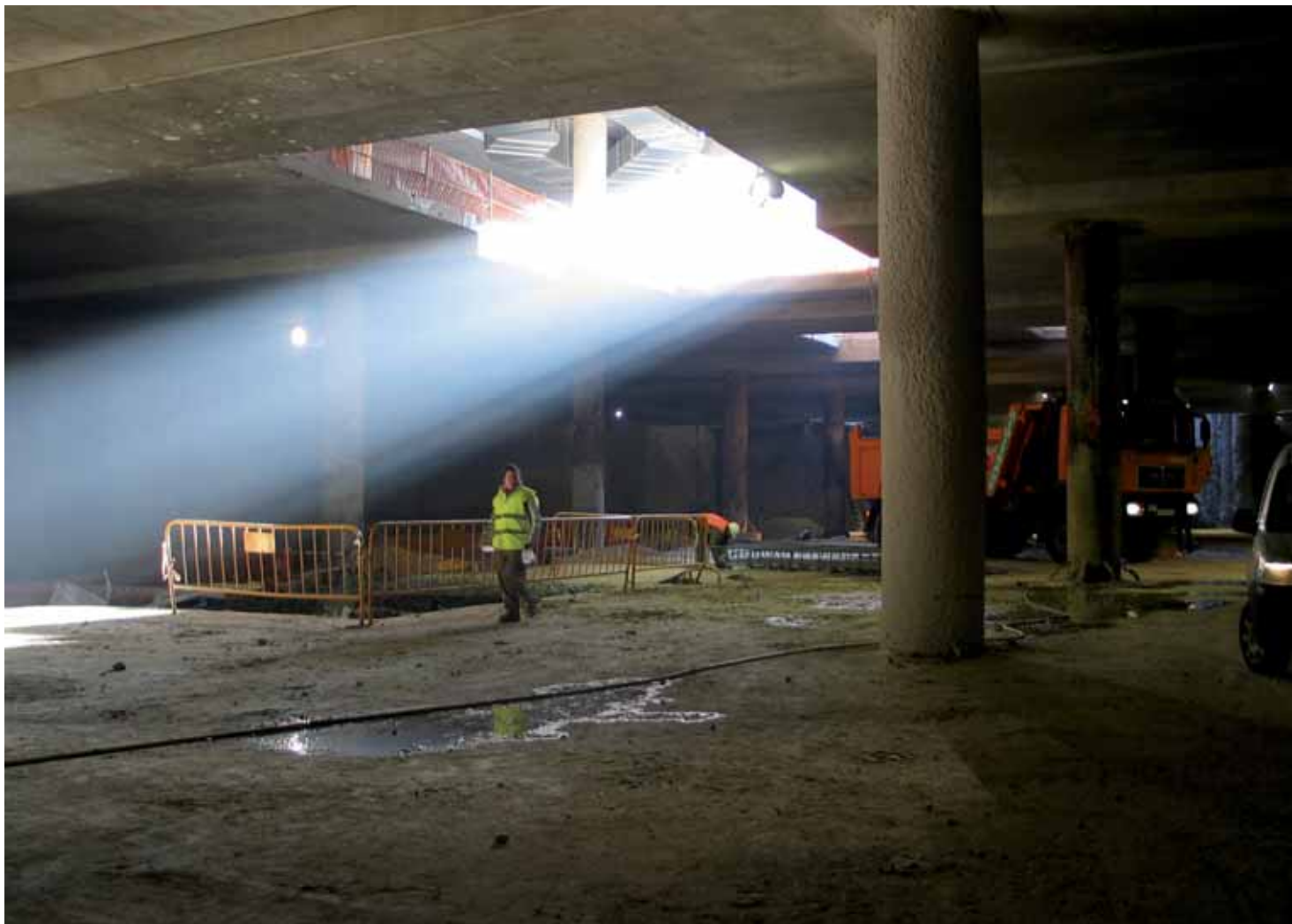
Excavación del nivel -1 Excavation of level -1
